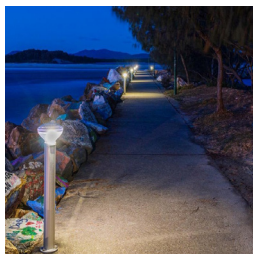
ILUMINACIÓN PASEO BORDE ESTERO
